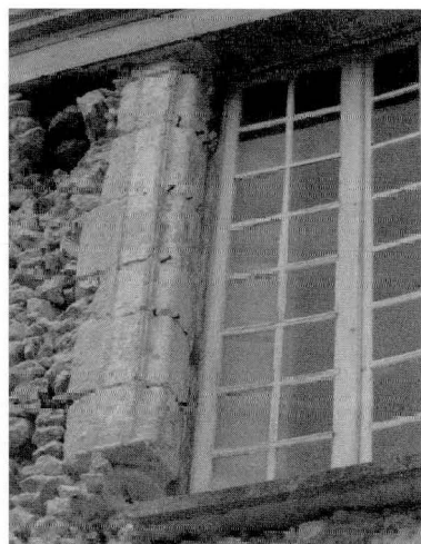
Le montant gauche de l'encadrement de la fenêtre centrale de l'étage de ce corps de logis.
